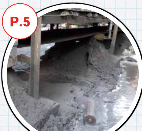
搬送物の落鉱
